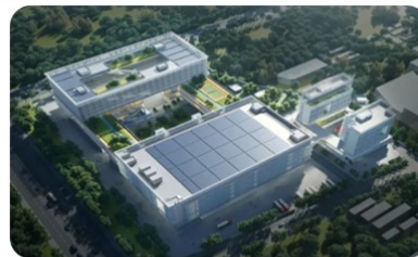
武汉海微科技股份有限公司 2.海微车载智能座舱研发产业化基地项目（二期） 洁净装修工程
