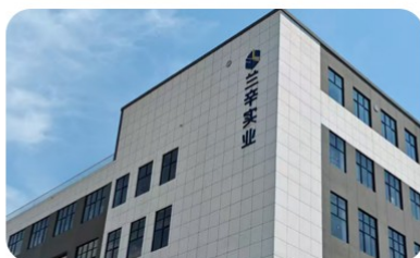
杭州科百特过滤器材有限公司 1、兰辛车间净化装修项目
