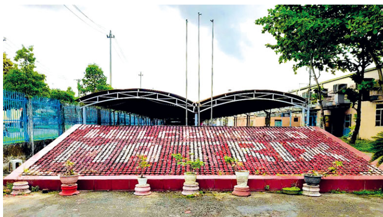
越南峴港市第三間廠房
