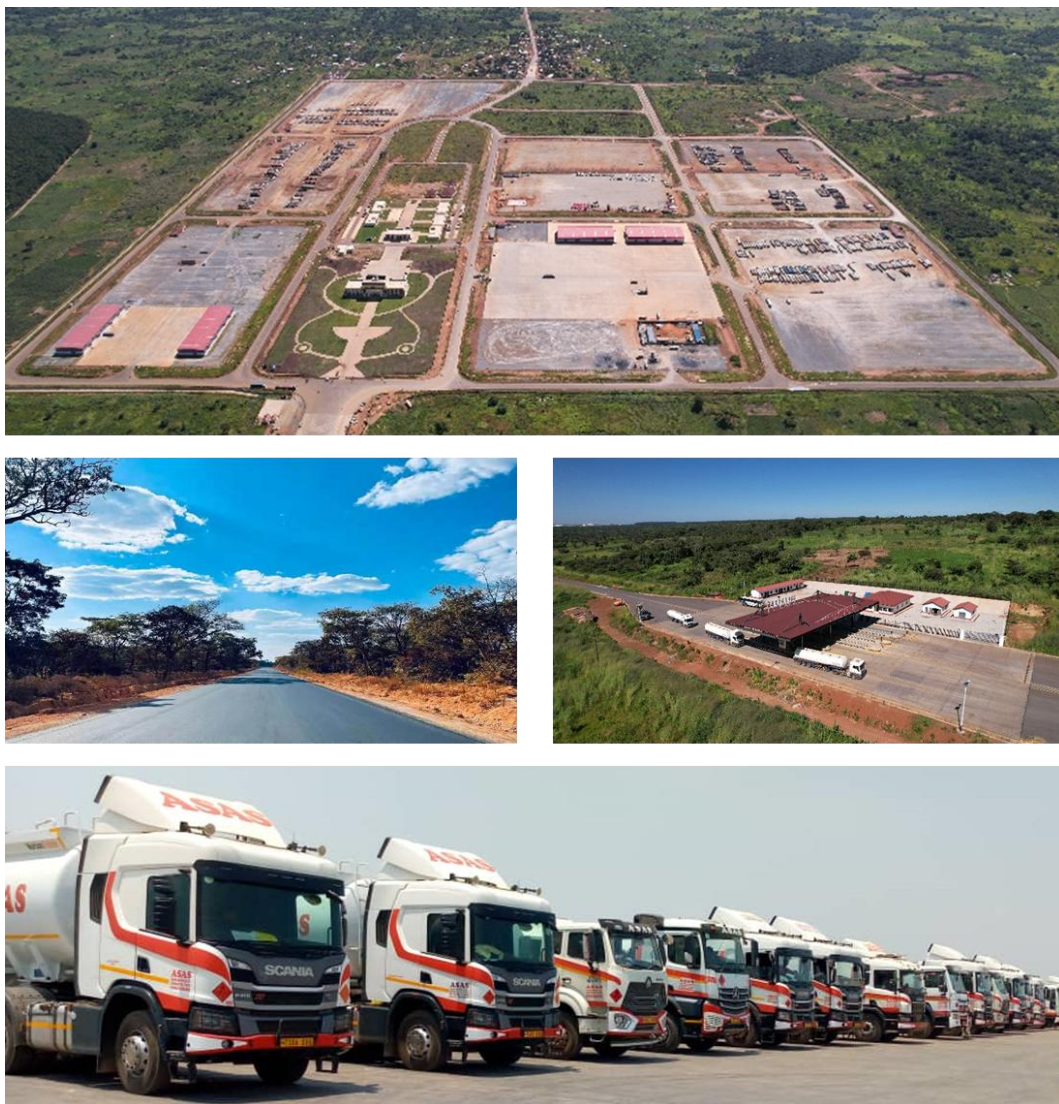
刚果（金）卡萨项目道路及陆港物流基础设施
