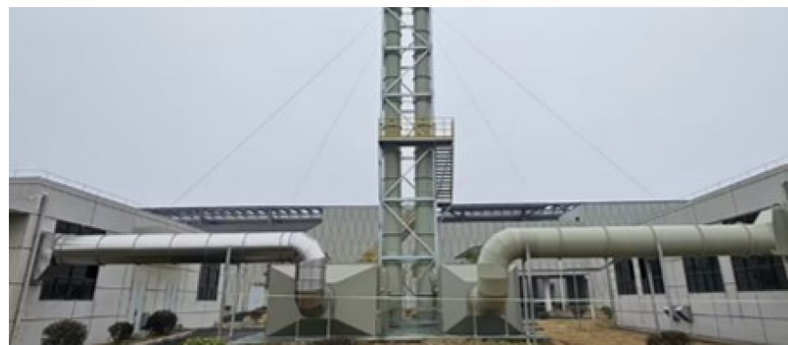
湖北三安废气处理设施改造
