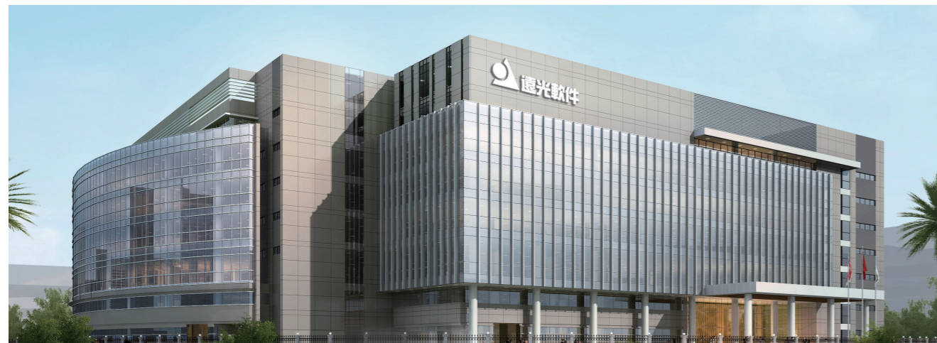
远光软件股份有限公司总部大楼
