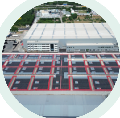
▲ 屋顶光伏建设
