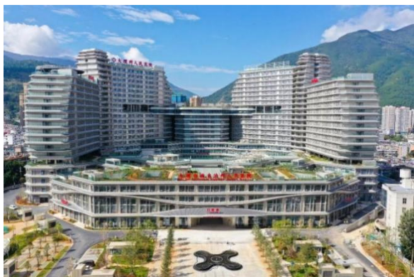
大理州人民医院实现竣工开业
