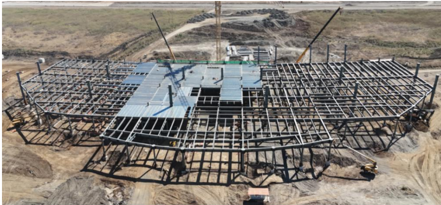
尼加拉瓜蓬塔韦特国际机场改扩建项目航站楼主体结构安装施工现场
