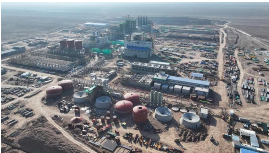
哈萨克斯坦年产50万吨纯碱厂项目施工现场
