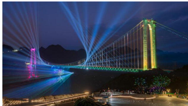
花江峡谷大桥主桥项目
