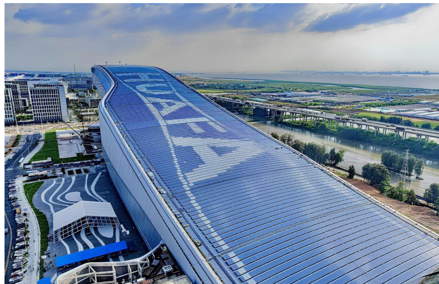
深圳前海冰雪世界铺设屋顶光伏系统
