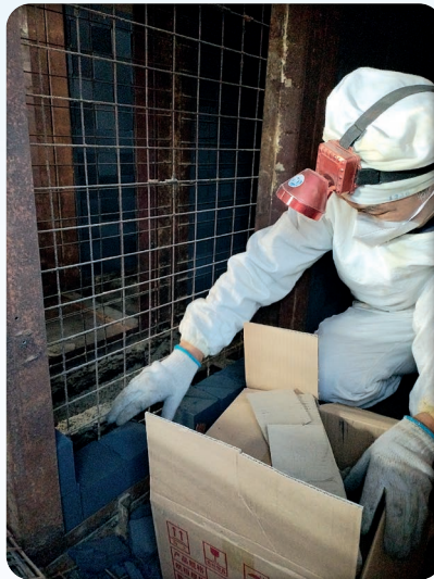
圖 1 北京生產基地每年定期對廢氣治理設備的活性炭進行更換
