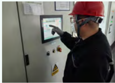
碳化车间废气超标排放应急演练
