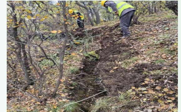
恢复治理工程施工
