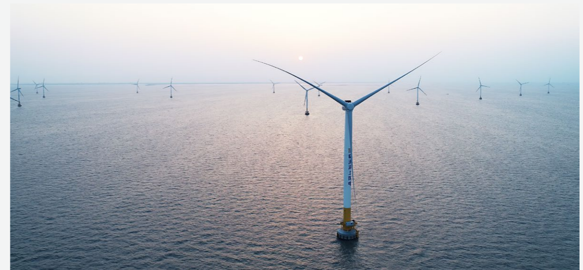
临港海上光伏项目
