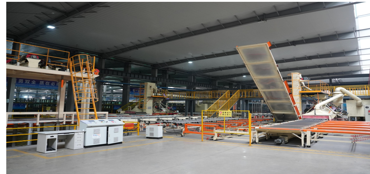
图注：鑫铂光伏二期项目厂区
