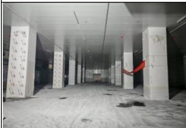
广西横州农夫山泉冷库分隔工程
