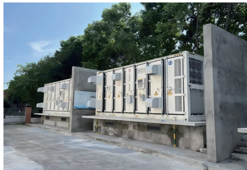
长城钨钼 5MW/10MWh 储能项目顺利竣工投运
