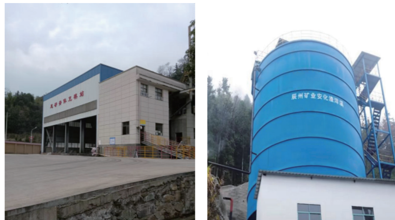
○尾砂膏体填充站
