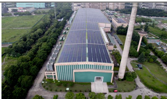
杭州某云计算数据中心项目
