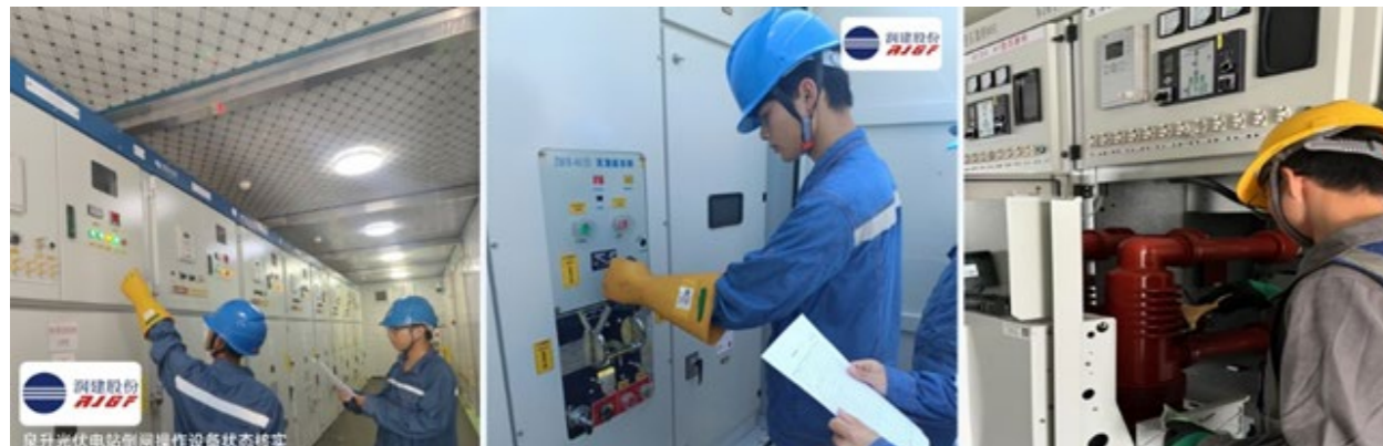
泉升光伏电站开展标准化倒闸操作与高压设备检修作业
