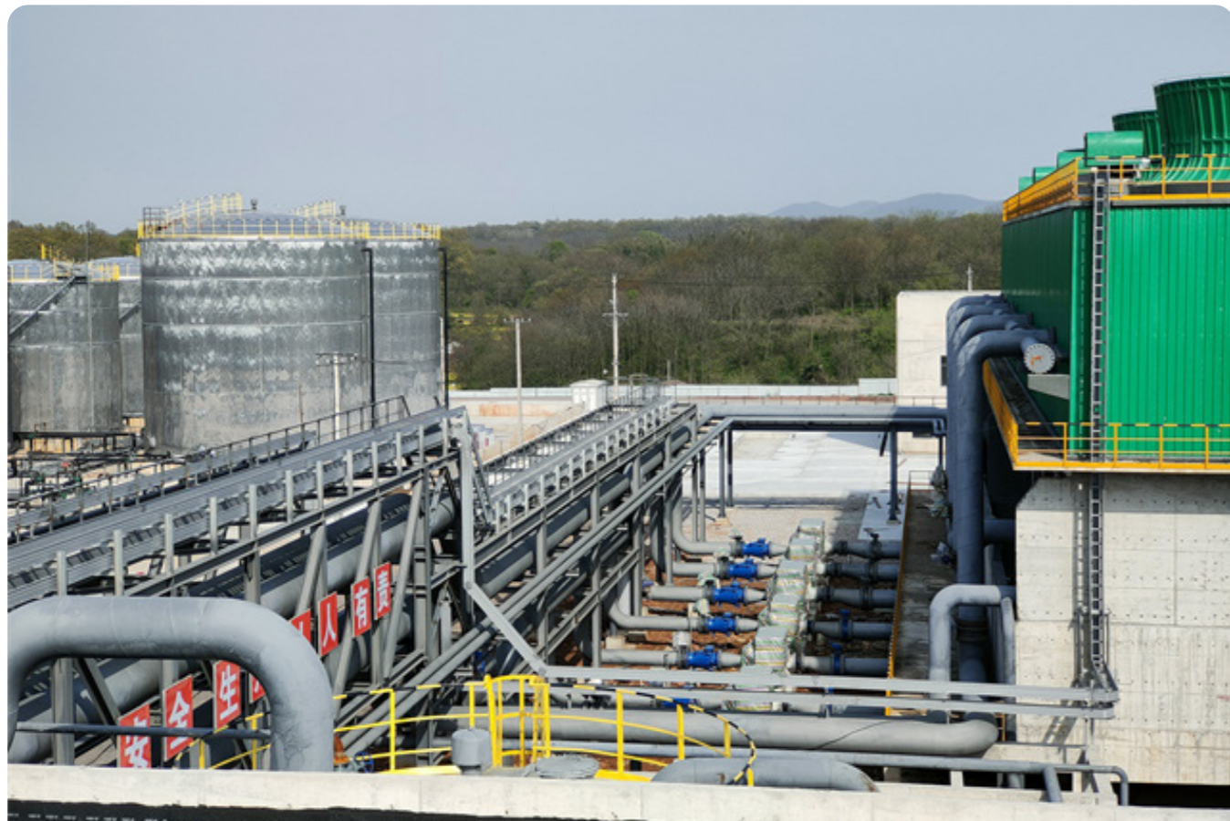
新洋丰荆门总部无水氟化氢项目
