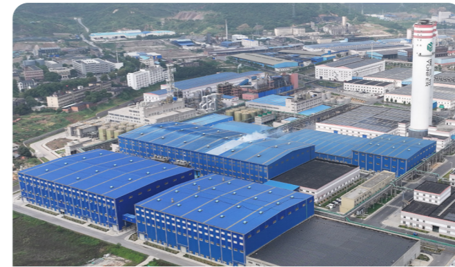
新洋丰磷酸铁项目
