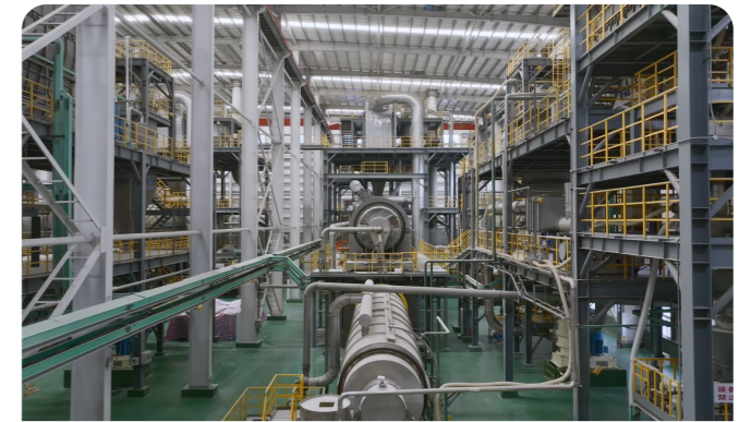
新洋丰磷酸铁生产车间
