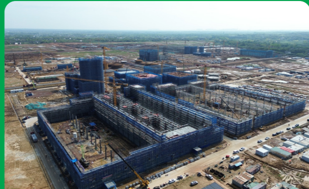
湖北宜昌磷系新材料循环经济产业园项目
