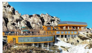
天山天池景区马牙山生态科普教育观光平台提升改造项目正式开工建设
