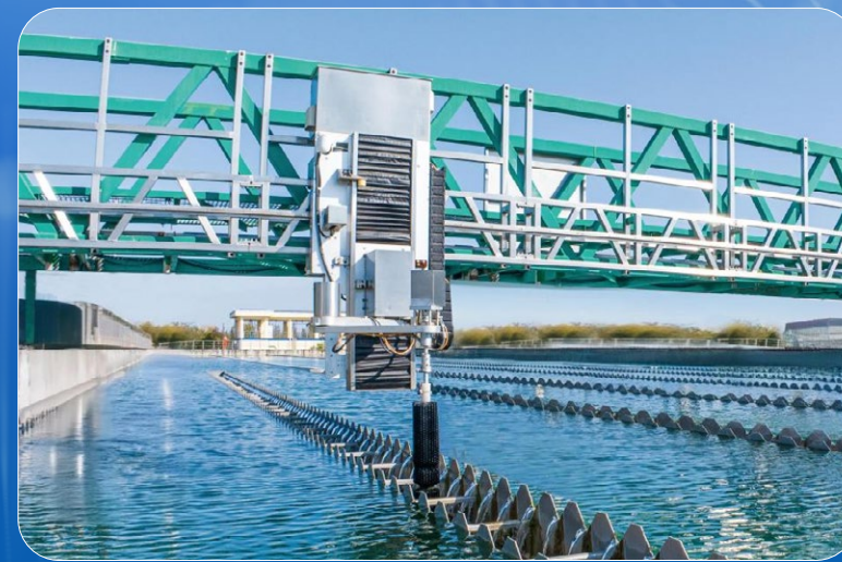
▲ 集水槽智能清洗机器人
