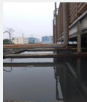
循环水池照片
