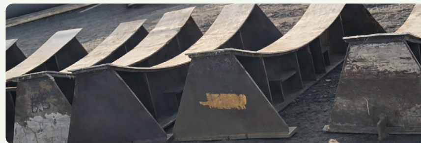
用废旧胶皮替代棉被进行塔筒底座保护
