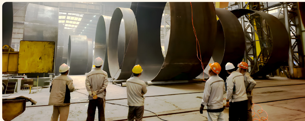
可调吊钩现场吊装工作
