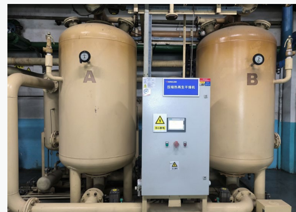
沈阳工厂压缩空气系统改造
