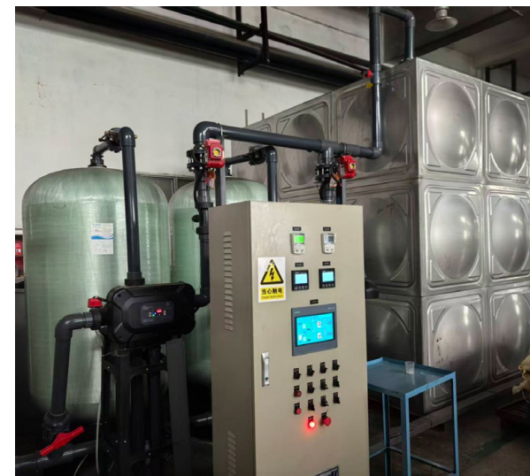
东营工厂软化水离子交换技术设备
