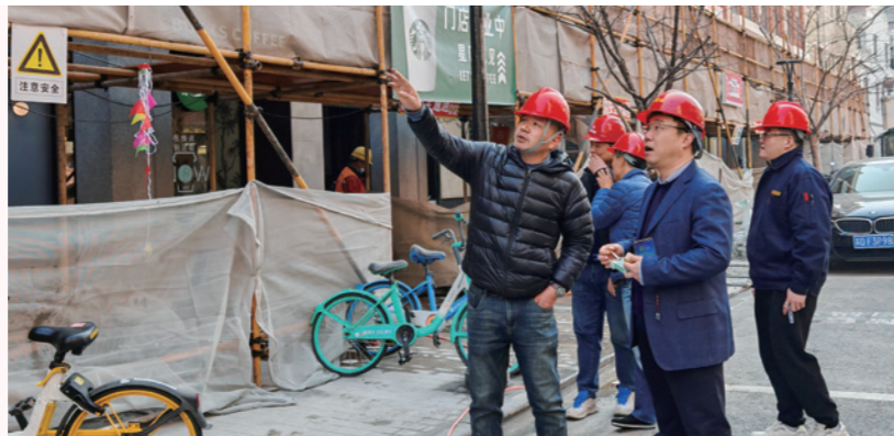
益民置业开展施工安全检查。
