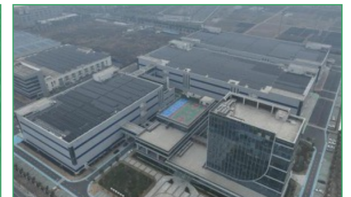
▲ 常州精测厂区屋顶 5.1437MW 分布式光伏发电系统
