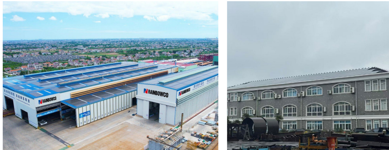
铺设屋顶光伏
