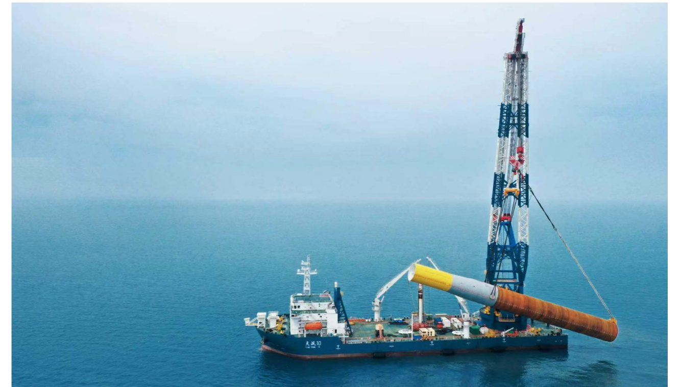
深远海海上风电高效安全施工作业船项目技术处于国际先进水平
