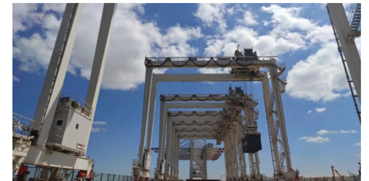
埃及达米埃塔港 40 台轮胎式龙门起重机（RTG）项目
