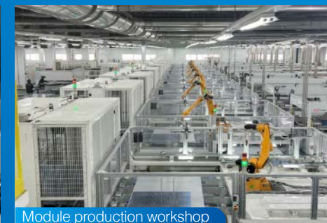
Module production workshop
