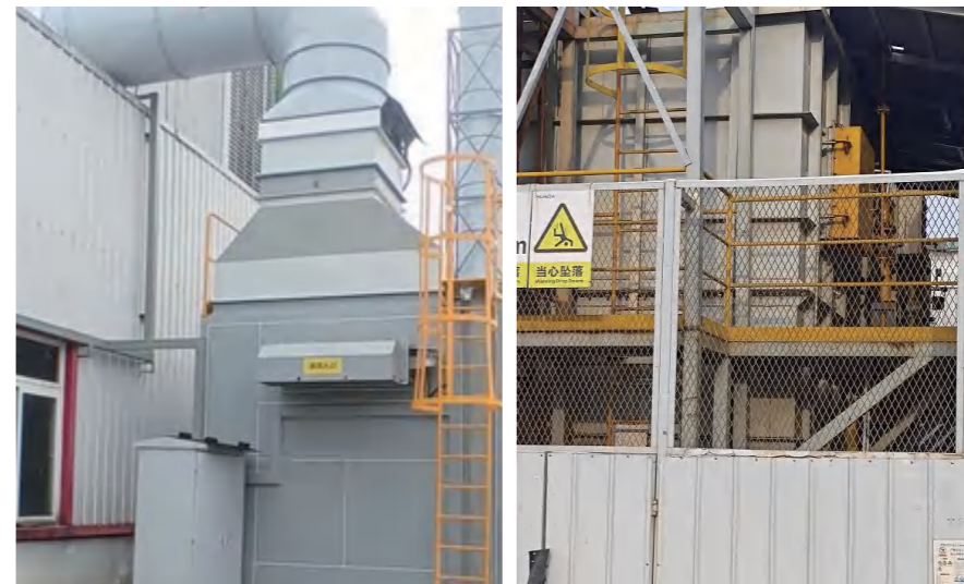
华翔科技长春工厂使用RTO装置对涂装、烘干等高浓度有机废气进行高温氧化处理。
