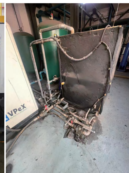
空压机余热回收系统
