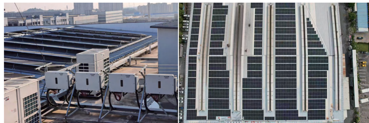
工厂安装光伏板
