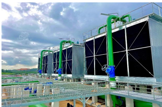
马来西亚柔佛州数据中心园区项目
