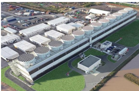
英国 Keadby 电厂二期项目
