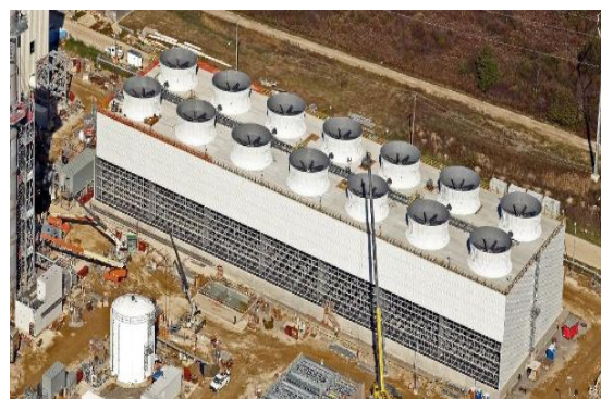
美国俄亥俄州 Lordstown 能源中心项目
