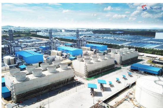
泰国电力项目
