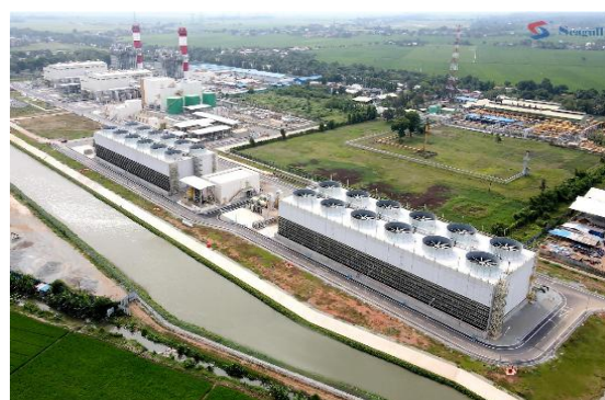
印尼 JAWA 一号电力项目
