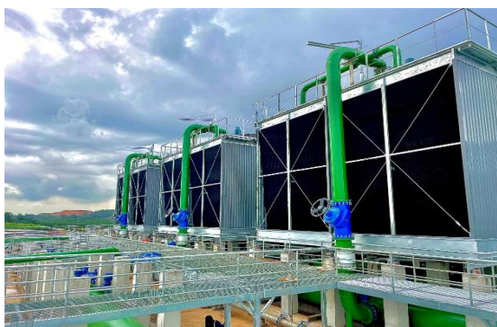
马来西亚柔佛州数据中心园区项目
