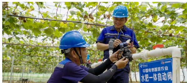
廣西公司員工為愛善現代農業莊園安裝智能控制設備
