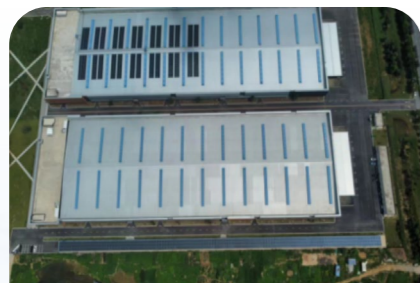
滁州产业园屋顶光伏板
