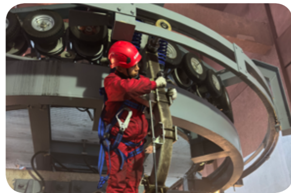
技术创新小组专项攻坚团队对摇臂结构进行更换
