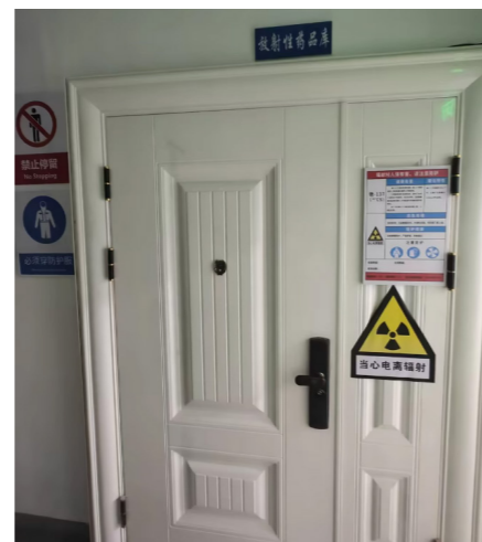
放射性药品专用存储库房
