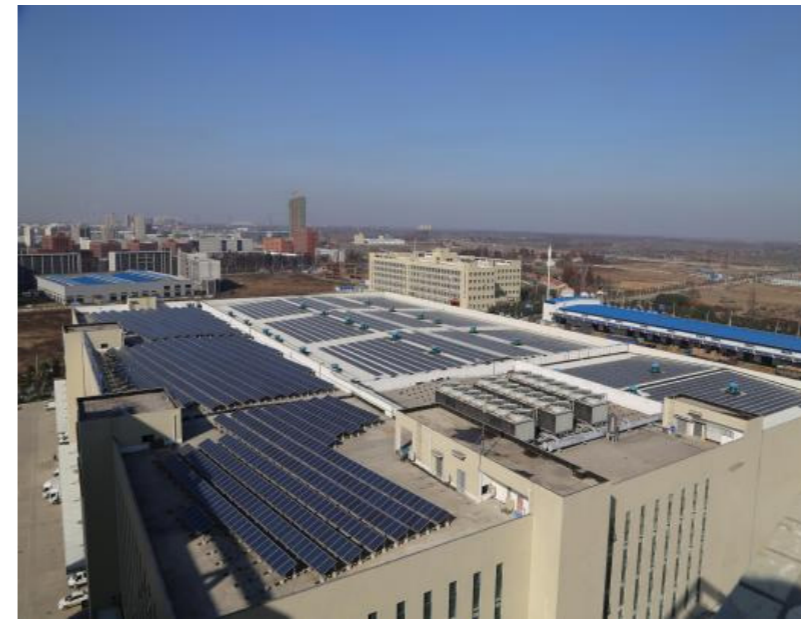
金寨九信光伏电站
