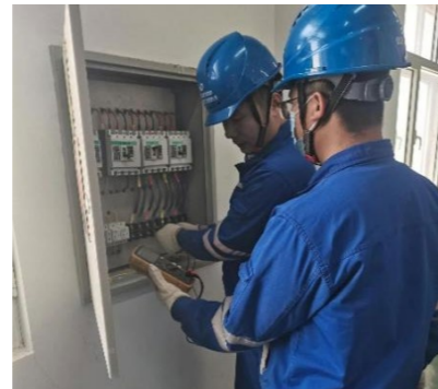
连接排水泵电源线
