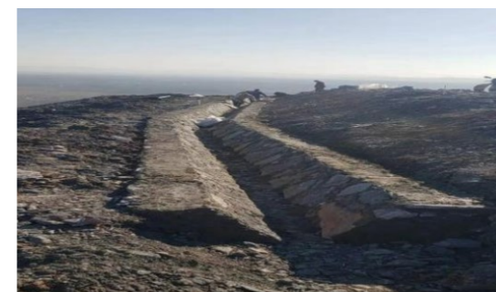
边坡防护栏和截水沟施工前后对比
