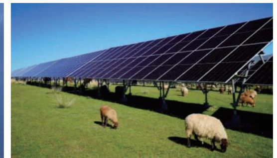
风光变流器和光伏逆变器在“沙戈荒”风光基地等场景示范应用（尼勒克400万千瓦风电光伏一体化项目）
