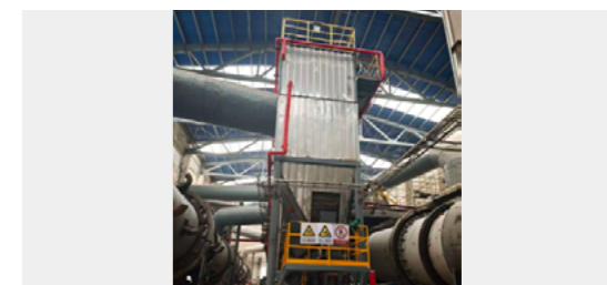
1# 线产线布袋除尘提升改造
