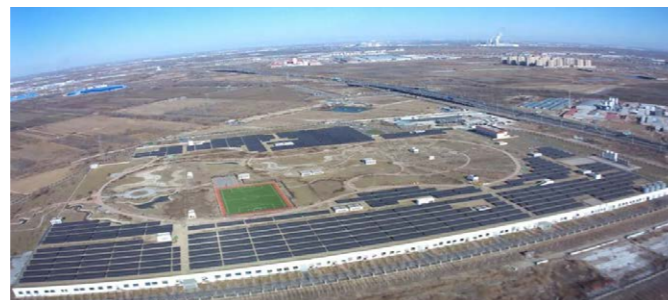
東郊污水處理廠分佈式光伏
