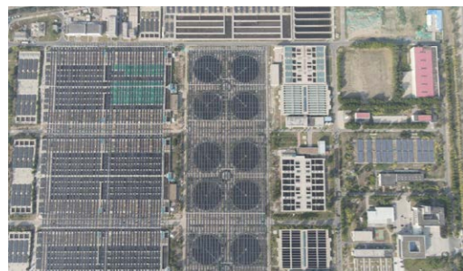
津沽污水處理廠分佈式光伏
