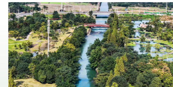
安德园区工业污水处理厂周边生态风貌
