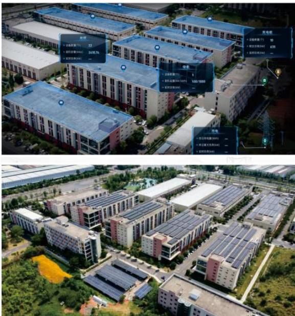
图2-4 智能微电网项目-简阳新经济产业园
