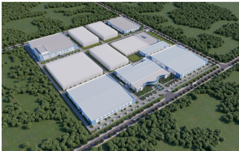
▲ 越南瑞勤电子厂房装修工程
