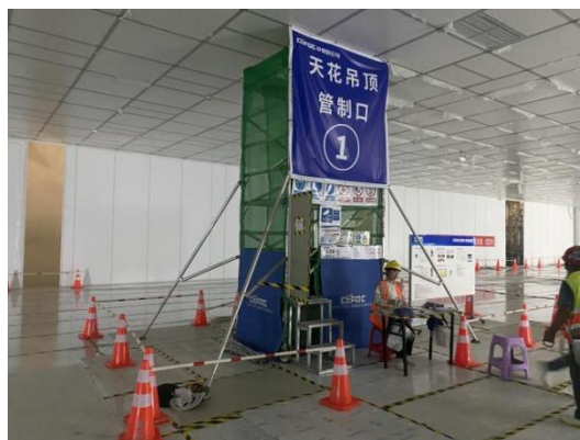
▲ 吊顶内作业管制场景
