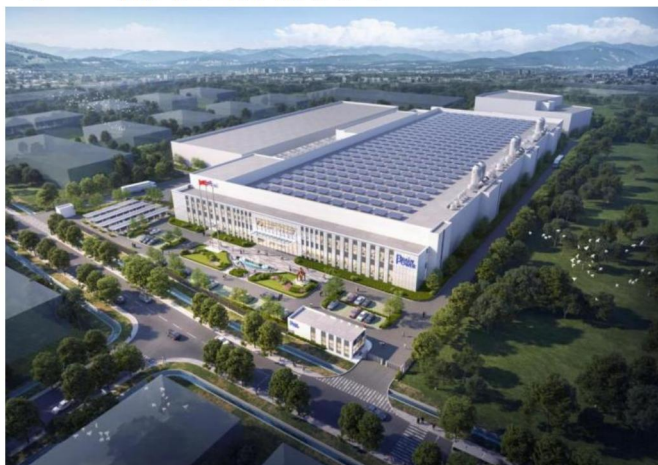
▲ 泰国欣强电子新建工厂建设施工总承包项目
