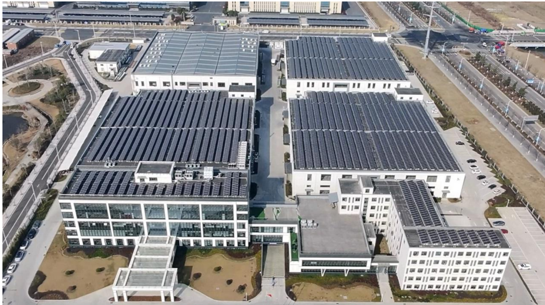
图一：厂房屋顶所配备的光伏发电系统
