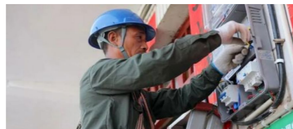
岳池爱众电力推进农网提质工程
