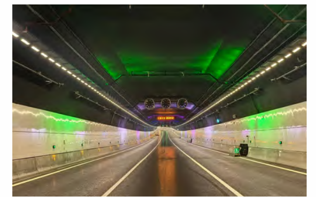
东六环隧道内的通风系统和疲劳唤醒带
