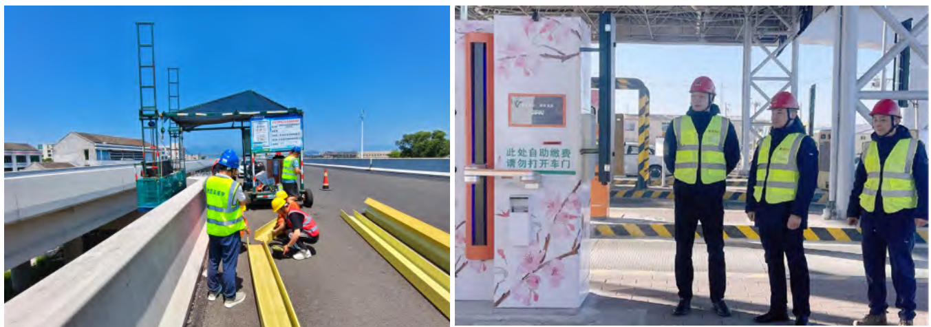
作业现场安全检查
