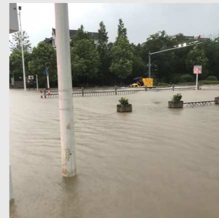
改造前汛期市政道路
