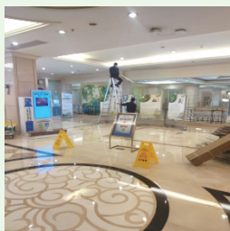
老舊高耗能燈具替換
