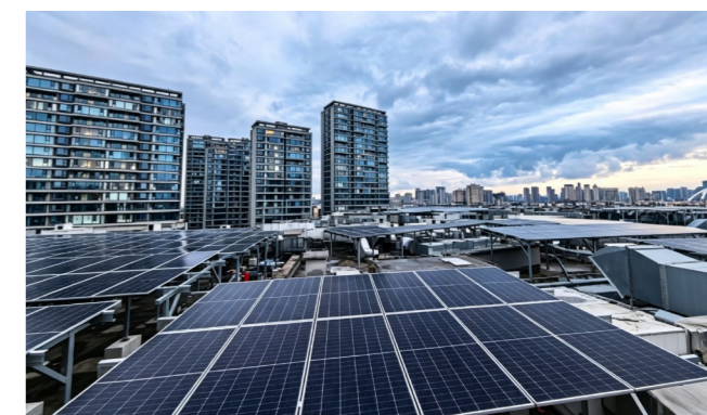
宁波海曙天街屋面光伏建设
