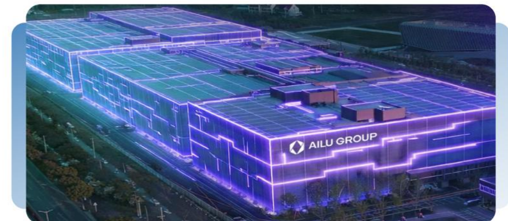
能源管理中心对能耗全局感知、实时掌控
